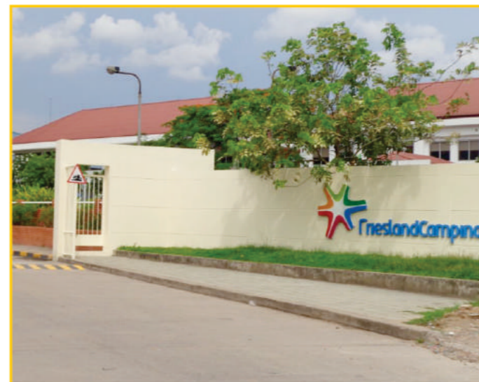
Nhà máy sữa Cô Gái Hà Lan - Hà Nam
